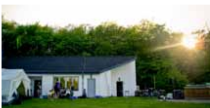
... mit Küche, großem Dusch- und WC-Haus ...
